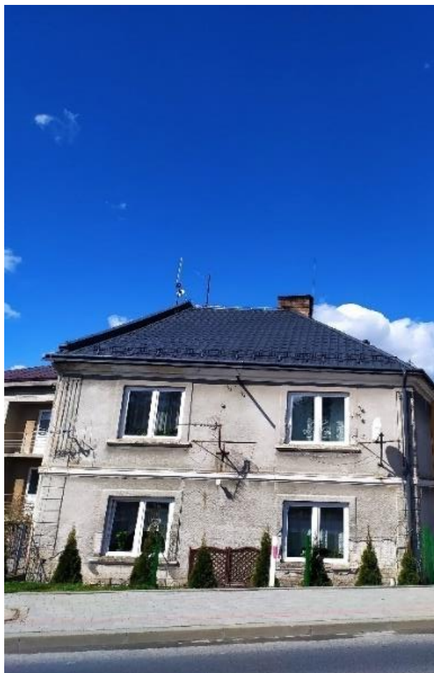
Fot. 18 Dach na budynku Lwowska 54
