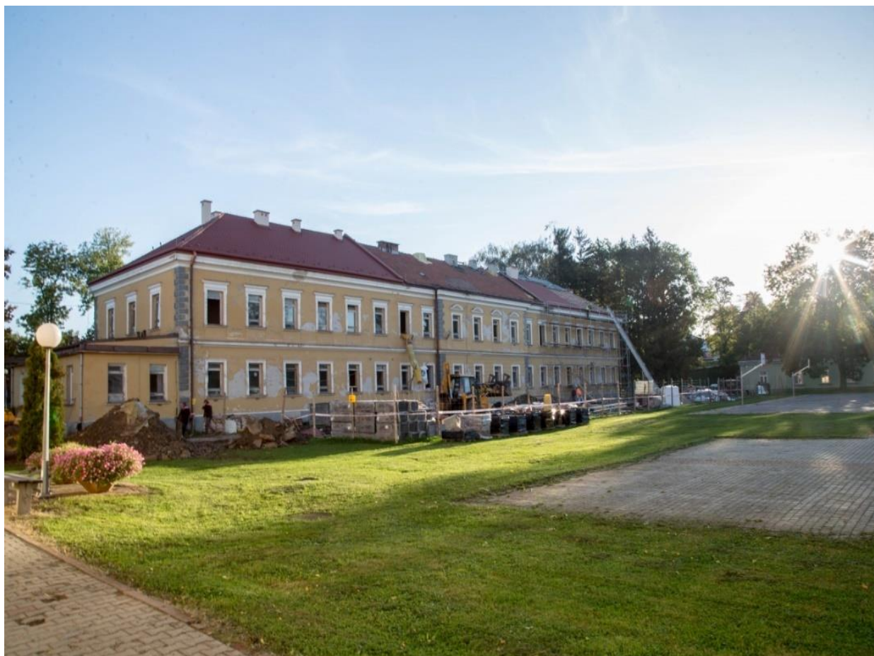
Fot. 9 Modernizowany budynek szkoły
